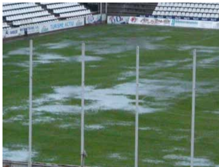
Aplicacions no agrícoles de la física de sòls: problemes de drenatge en un camp de futbol.
