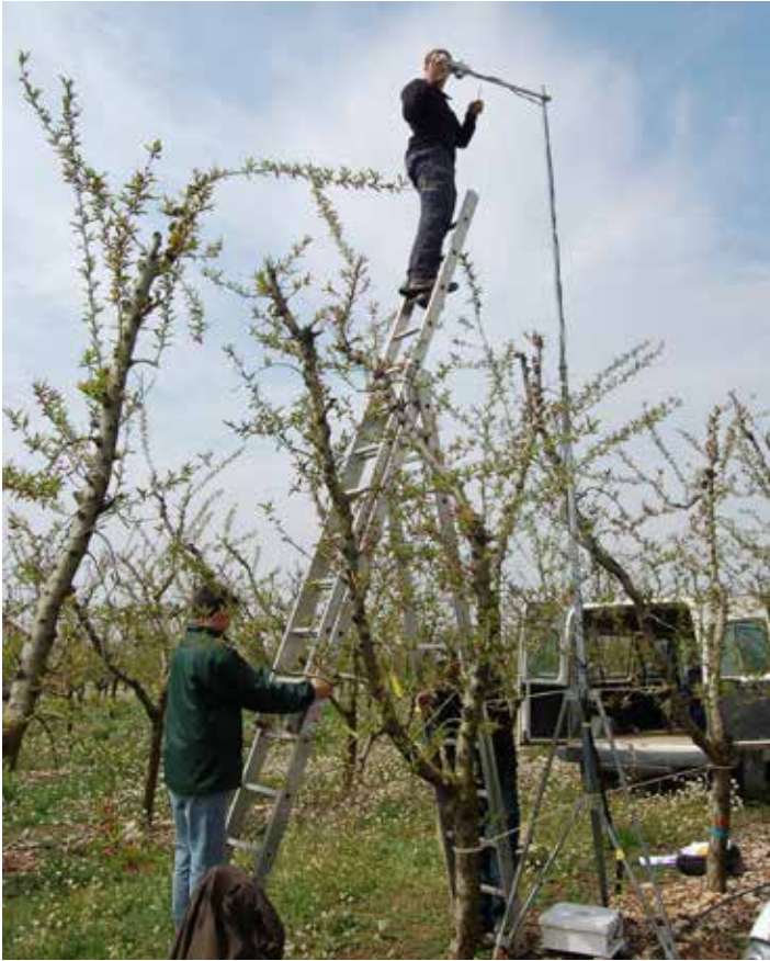
Instal·lació d'una estació agrometeorològica en un camp experimental. (J. M. Villar, 2011).
